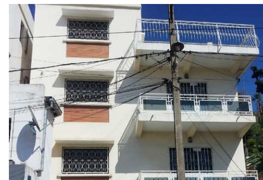
Lot II 44 Bis Ankadivato, nouveau siège de la Fondation depuis 2015 • Lot II 44 Bis Ankadivato, new headquarters of FAPBM from 2015
